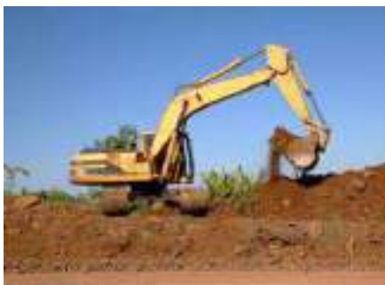
Traçage des voiries
