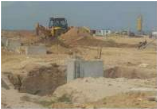
Lancement des travaux d'aménagement
