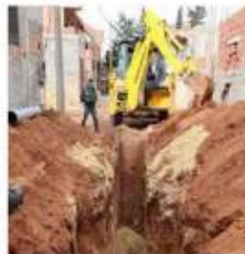
Réhabilitation des réseaux
